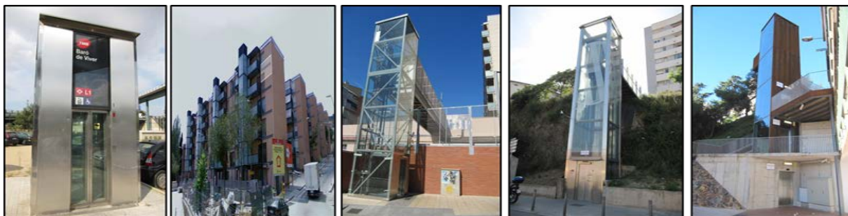
Diferents ascensors sense cambra de màquines
