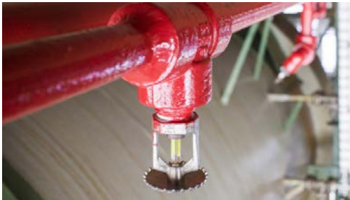
Instal·lació de ruixadors. Font: previfoc.com
