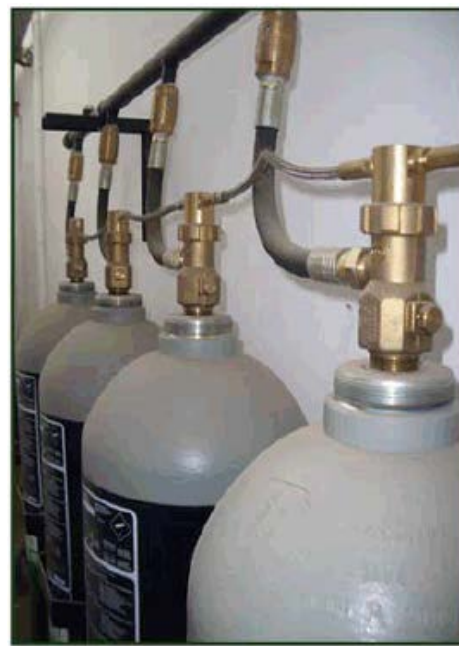
Grup d'ampolles de CO2 a pressió. Font: tyco-fire.com
