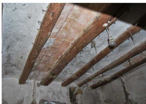
Sostre de bigues de fusta i revoltó vist
