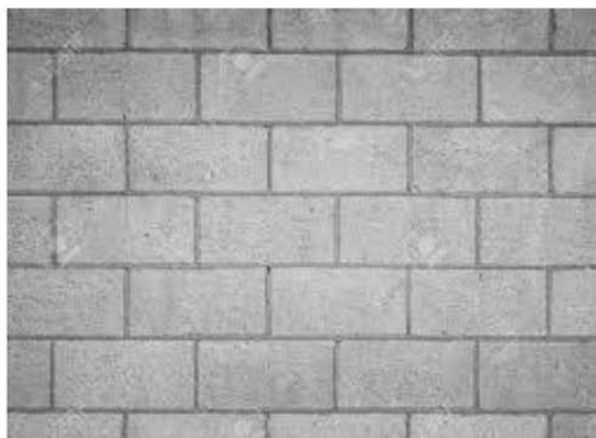
Mur de blocs de formigó
