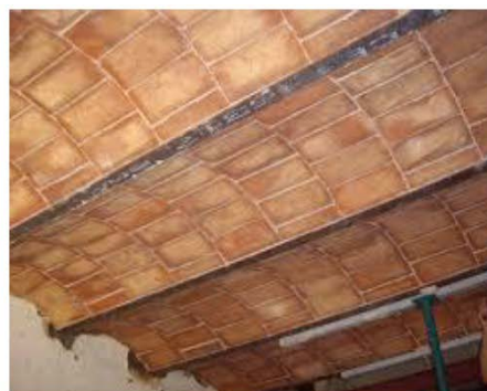
Sostre de bigues metàl·liques i revoltó vist
