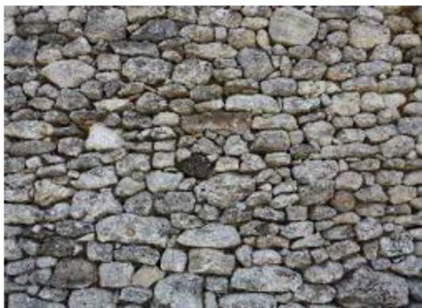
Mur de paredat, o mur de pedra
