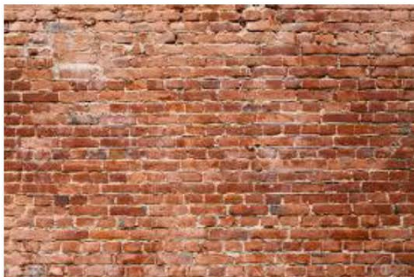
Mur de maons, o de fàbrica ceràmica
